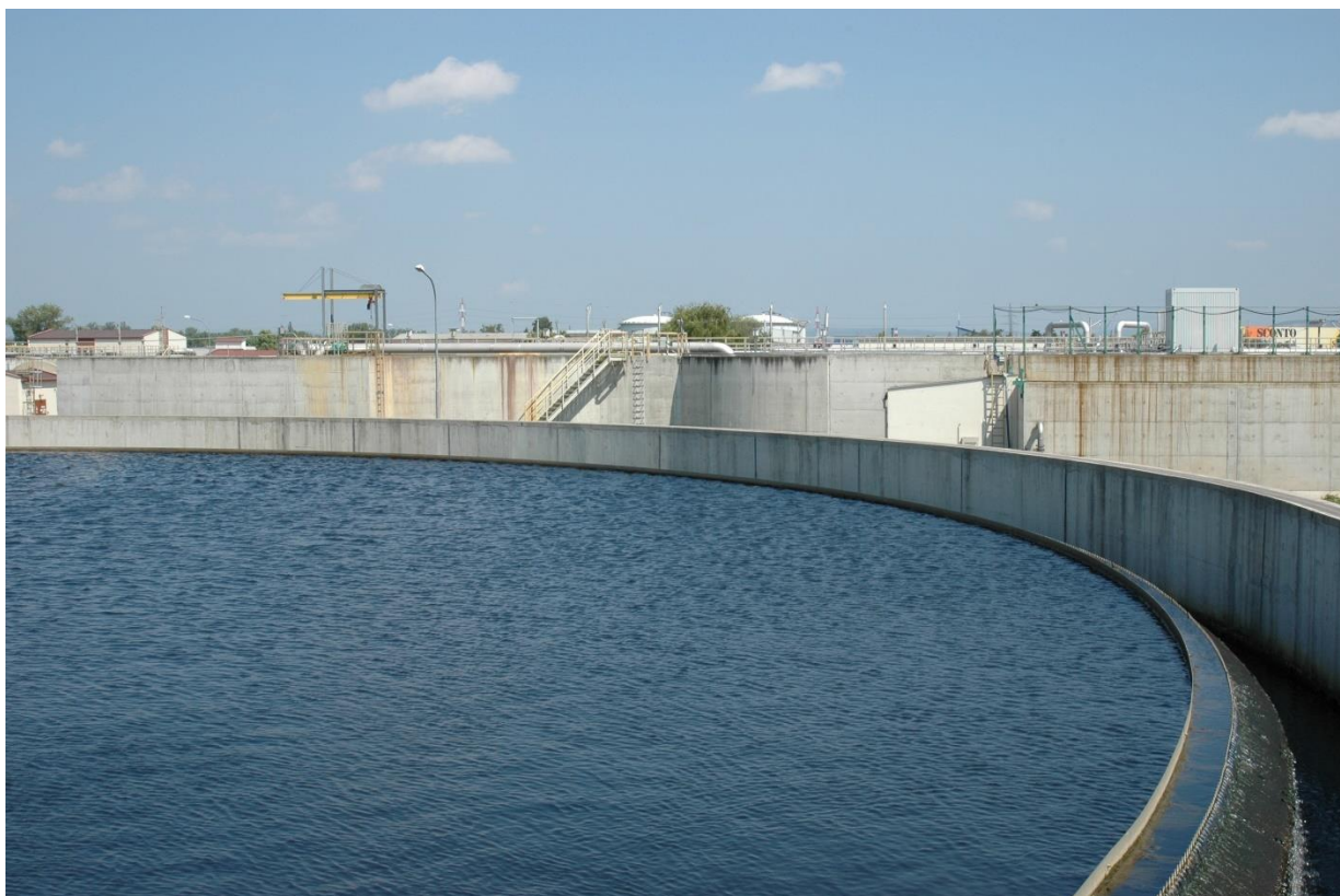
Obr. 13: ČOV Modřice, dosazovací nádrž
